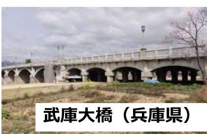
(4) コンクリート橋
